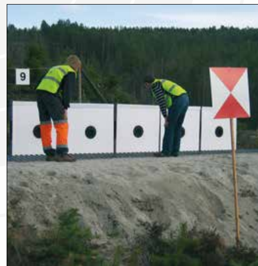
Korrekt merking og bekledning.
