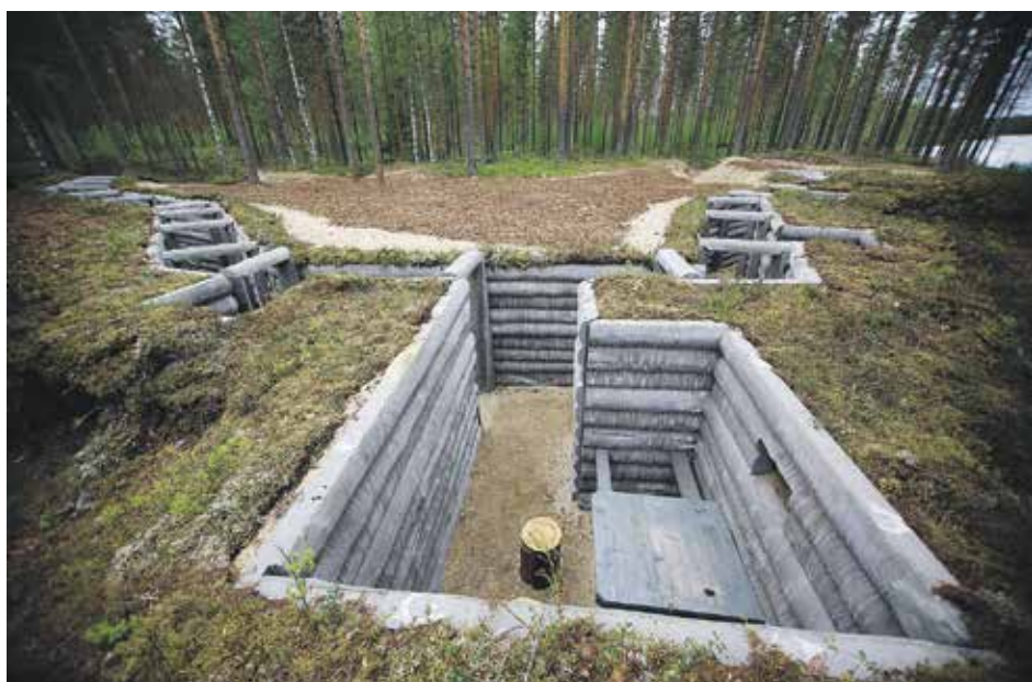
Änäkäisen Salpaetuasema entisöitiin 2017. Ensikertaa taisteluhauta kunnostettiin kelojujäljitelmäbetonielementeistä. Änäkäisen Salpalinja on yksi maamme edustavimmista Salpa-kohteista panssariesteineen ja luolastoineen. Änäkäinen sijaitsee Lieksasta 35 km Kivivaarantietä, paikassa minkä kautta kulkee tunnettu Karhunpolun 133 km mittainen vaellusreitti.
